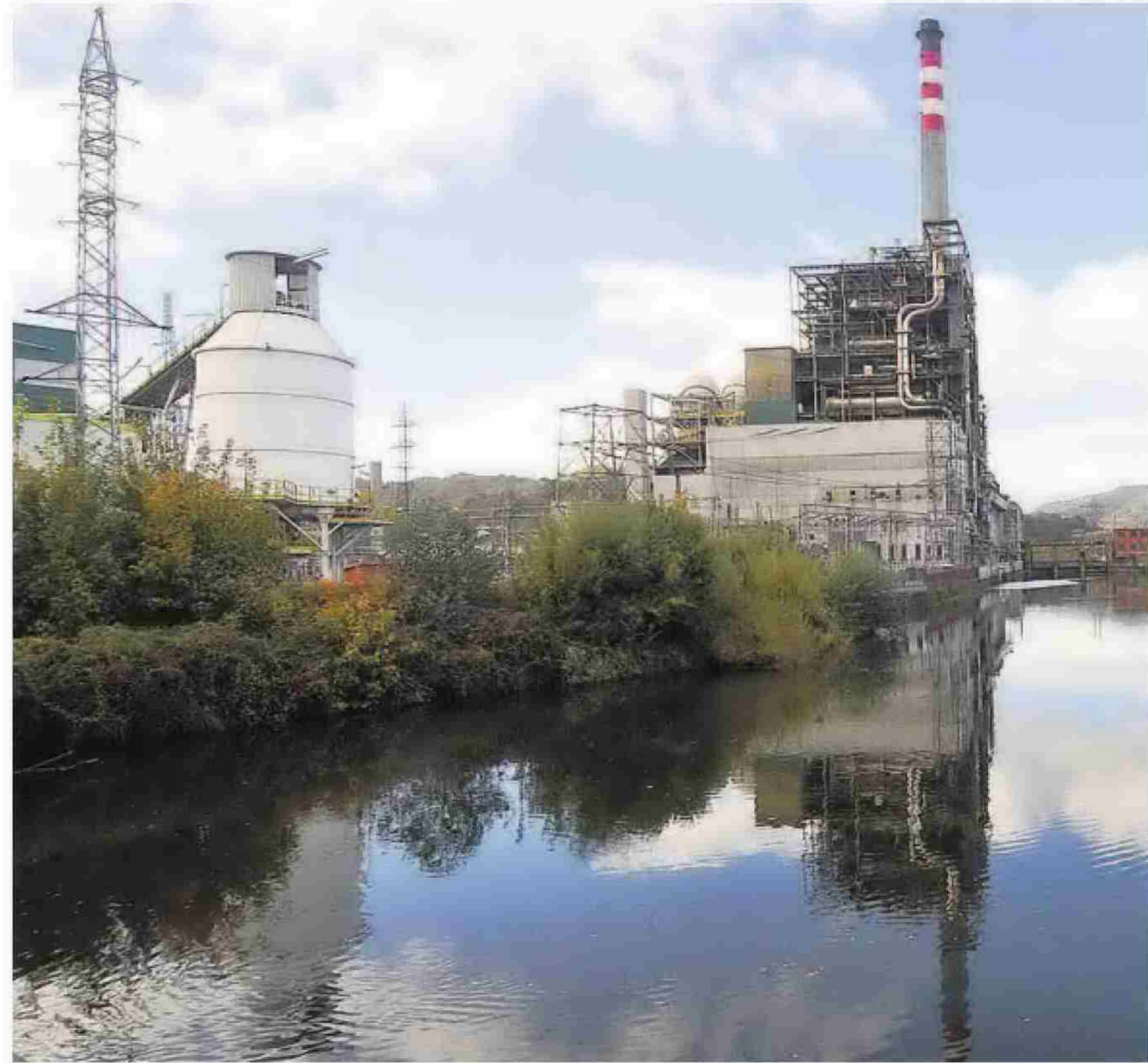
Instalaciones de la central térmica de Lada, con el río Nalón en primer término. | FERNANDO GEIJO
