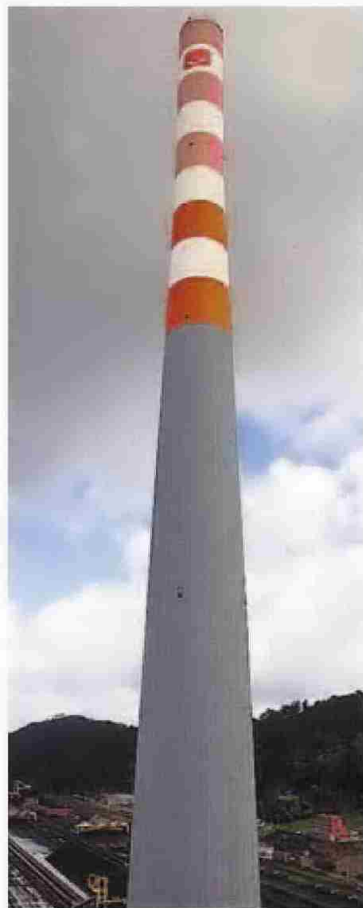
La chimenea de la térmica de Aboño. | MARCOS LEÓN
